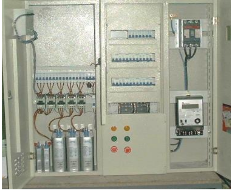
Resim 1.12: Orta büyüklükteki bir tesisin alıcılarının kompanse edildiği merkezi kompanzasyon panosu
