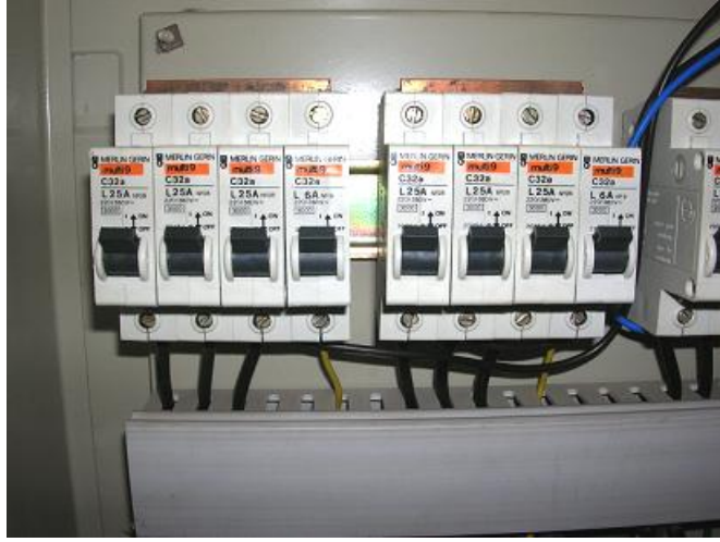
Resim 1.5: Kompanzasyonda kullanılan sigortalar
